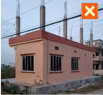
चित्र ३४: एक नाल भएका भवन
