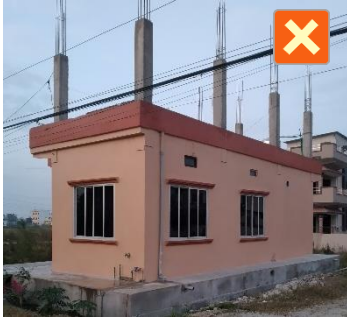
चित्र ३४: एक नाल भएका भवन
